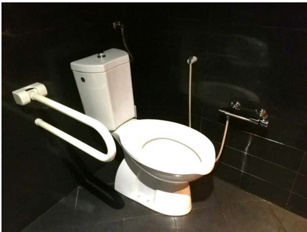
Particolare wc e maniglione ribaltabile
