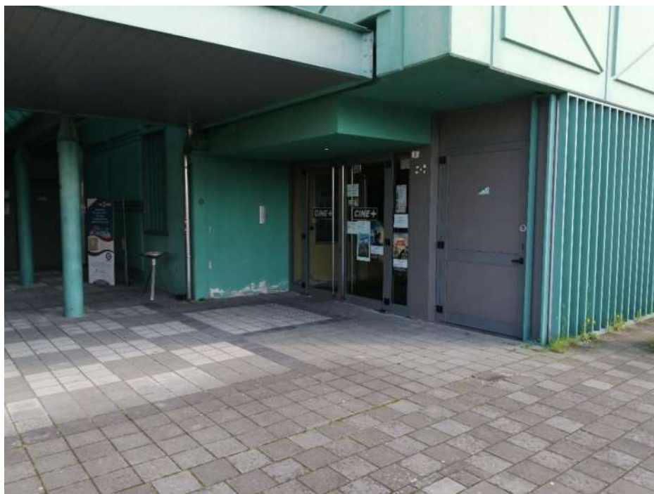
ESTERNI – Ingresso cinema
